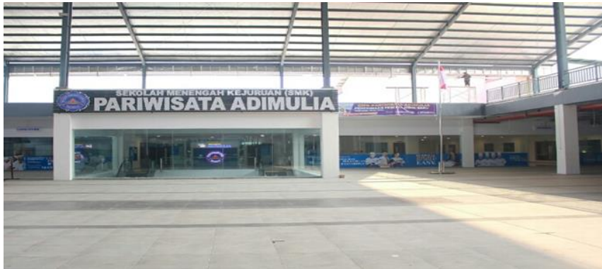
Gambar 2. Lokasi gedung SMK Pariwisata Adimulia
